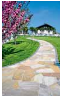
Natursteinplatten polygonal verlegt
